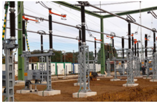
Výstavba ES 245 kV Opočíněk
