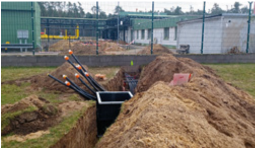
Obnova NN rozvodov Nafta a.s.
