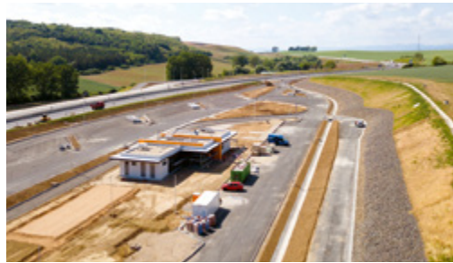
Odpočívadlo na rýchlostnej ceste R4 Košice - Milhost'
