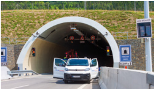
Tunnel Považský Chlmec
