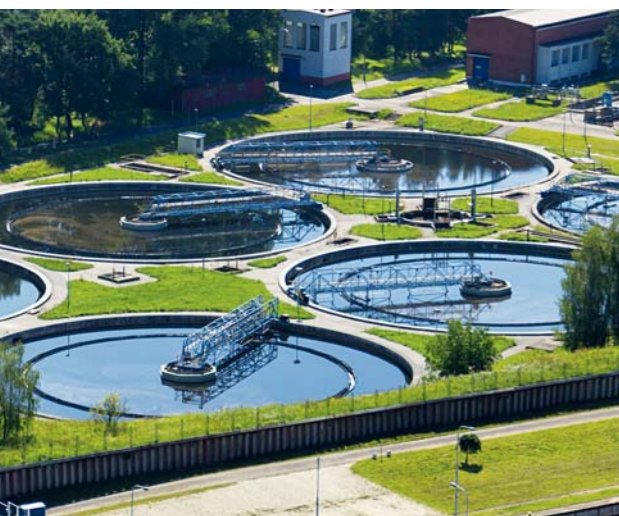
Čistička odpadových vôd
