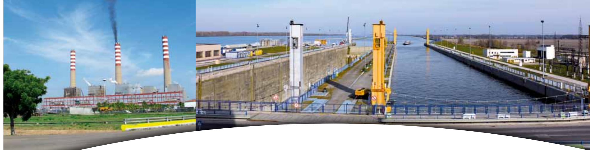
Tepelná elektrárň Planta Centro, Venezuela
